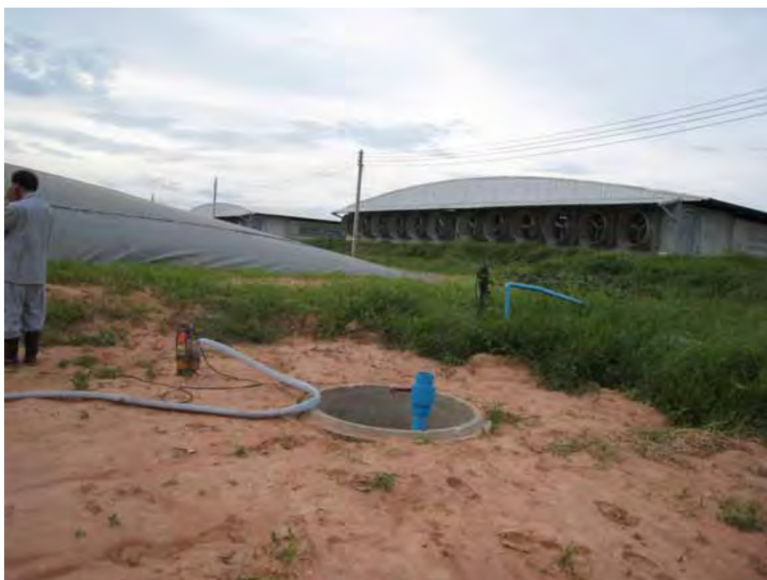
図 2.3.1 カバー先行設置の養豚場（Chaturat）の現状〔メタンガスは大気中に放出〕
