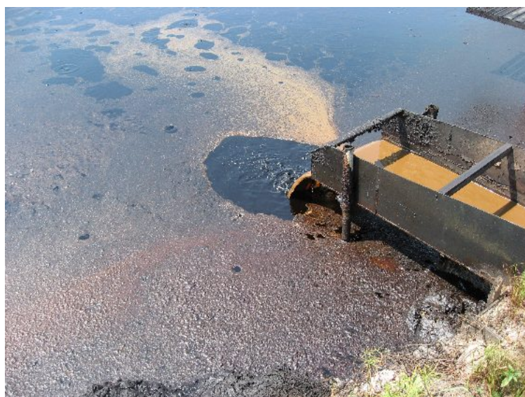
Cooling Pond (Preliminary Anaerobic Pond) に排出される POME
