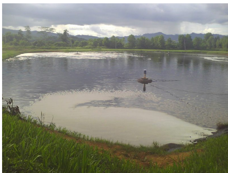
エアレーターの付いた Aerobic Pond
