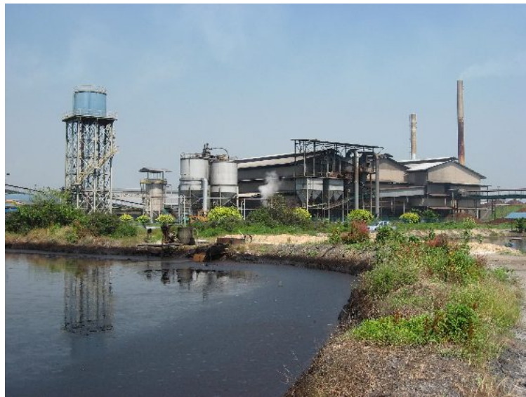
Rinwood 社パームオイル工場の全景
