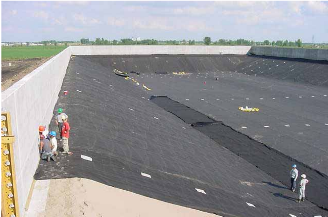
図 2.2.3 メタン発酵槽（ラグーンタイプ）の設置状況
