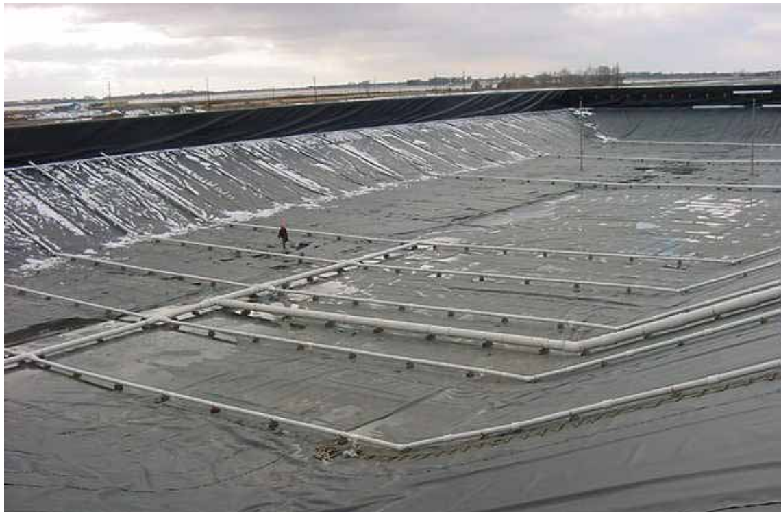
図 2.2.4 メタン発酵槽（ラグーンタイプ）の斜面、底部の設置状況
