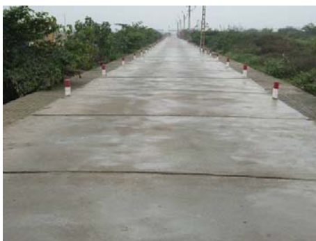
敷地内搬入路（コンクリート舗装）
