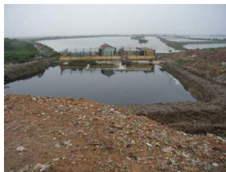
浸出水処理施設
