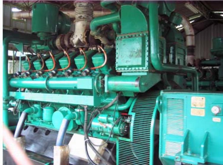
バイオガスエンジン 500 kW (中国製)
