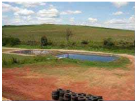
図表 5-9 浸出水調整池
