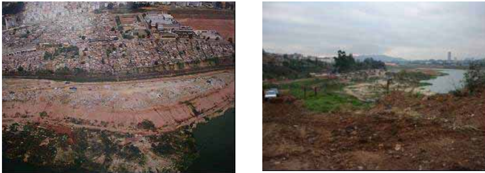
図表 5-5 カラピクイバ市の Landfill サイトの位置（左：全景、右：Landfill サイト頂上からの眺め）
