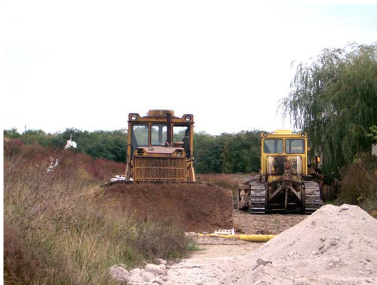
写真 2.1-2 処分場の現状 (2)
