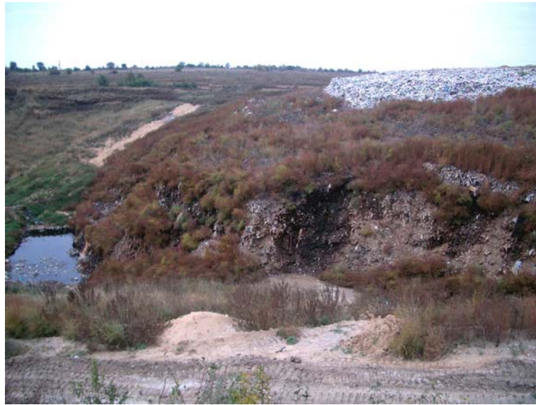
写真 2.1-1 処分場の現状 (1)
