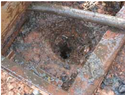
図 4-18 ボーリング孔周辺
