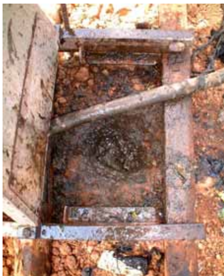
図 4-20 ボーリング孔からの貯留水の噴出し
