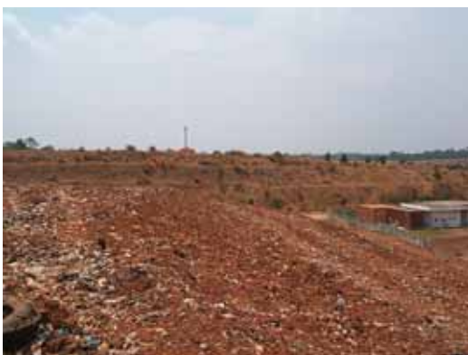
図 4-3 処分場表面の植生
