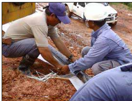
図 4-14 不織布を巻いた有孔塩ビ管
