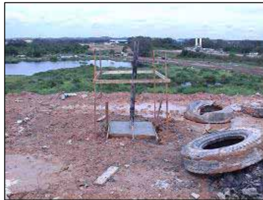
図 4-15 完成した産出井戸 5
