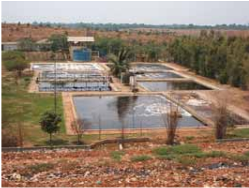
図 4-7 浸出水処理施設
