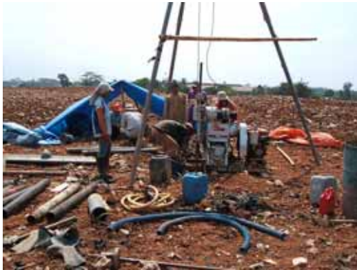
図4-16 ボーリング作業
