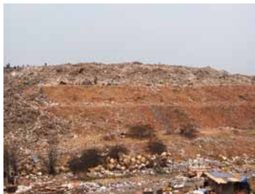
図 4-2 処分場全景(埋立進行部)
