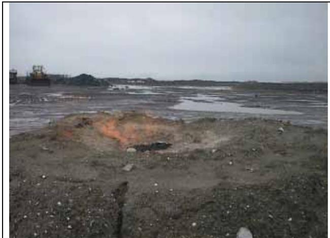
写真3-3 ガス抜き井戸によるメタンガスの燃焼処理（毛萱子埋立場）
