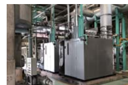
No.22 関西電力(株) … 繊維工場及び食品工場への高効率ボイラ、高効率ターボ冷凍機、太陽光発電システムの導入
