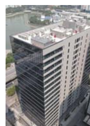
No.21-2 (株)カネカ … タイにおける高層建築物への高意匠高効率壁面建材一体型太陽光発電システムの実証
