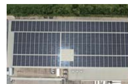
No.11 大阪ガス(株) … 金属加工工場及び冷凍倉庫への2.9MW屋根置き太陽光発電システムの導入による電力供給
