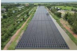
No.21 自然電力(株) … 工場群への18.9MW屋根置き太陽光及び水上太陽光発電システムの導入
