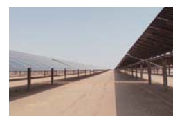
No.9 丸紅(株) … ラービグ地域における400MW太陽光発電プロジェクト
