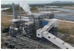
No.3 丸紅(株) インスタントコーヒー製造工場への バイオマスボイラーの導入
