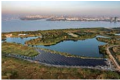
No.13 東京センチュリー(株) ヤンゴン市における4.3MW太陽 光発電プロジェクト
