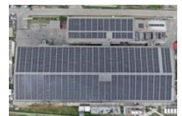
No.26 東京センチュリー(株) 食品工場への1.3MW太陽光発電システムの導入(JCMエコリース事業)
