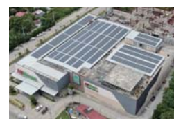
No.5 東京センチュリー(株) 配電会社と連携した9.6MW太陽光発電プロジェクト
