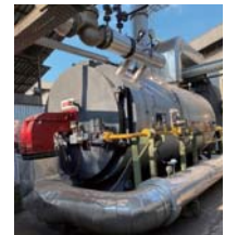
No.5 フマキラー(株) 化学工場への高効率熱媒ヒーターシステムの導入
