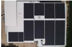
No.2 シャープエネルギーソリューション(株) スーパーマーケットへの1MW屋根置き太陽光発電システムの導入
