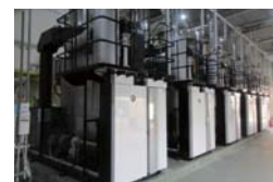
No.4 エースコック(株) 食品工場への高効率ボイラシステムの導入
