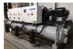
No.9 関西電力(株) 機械工場への省エネ型ターボ冷凍機の導入
