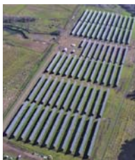
No.20 ファームランド(株) ニュブレ州チジャン市における3MW太陽光発電プロジェクト
