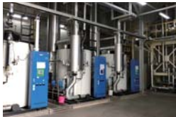
No.12 日本紙パルプ商事(株) ダンボール生産工場への高効率ボイラーシステムの導入
