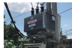
No.2 裕幸計装(株) 南部・中部地域の配電網にお けるアモルフラス高効率変圧器の 導入II
