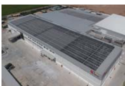
No.24 (株)兼松KGK 食品工場への0.8MW太陽光 発電及び高効率冷凍機の導入
