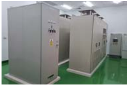
No.3 横浜ウォーター(株) インバーター導入による取水ポンプの省エネルギー化
