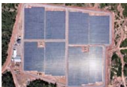
No.20 シャープエネルギーソリューション(株) サワンナケート県における11MW 太陽光発電プロジェクト
