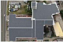
No.6 シャープエネルギーソリューション(株) スーパーマーケットへの0.4MW 屋根置き太陽光発電システムの導入
