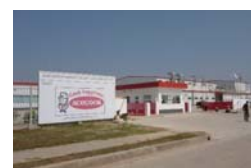
No.17 即席麺工場への高効率貫流ボイラの導入(工場外観)
