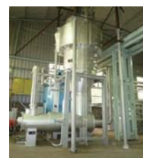
No.15-5 加熱水蒸気発生装置・ 乾留ガス燃焼装置(部分)
