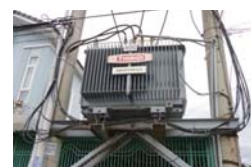
No.14 送配電網におけるアモルフアス 高効率変圧器の導入 (ベトナム)
