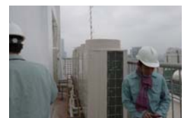
No.12 ホテルへの高効率インバーター・エアコンの導入(テラスに設置された室外機)
