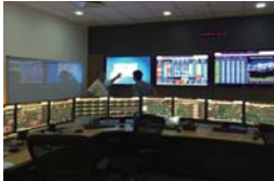
No.14-4 地域冷房プラント 中央監視室 (最適制御システム組込予定)
