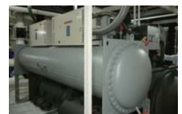
No.17 半導体工場における省エネ型冷凍機・コンプレッサーの導入(冷凍機)
