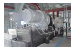
No.8 省エネ型ターボ冷凍機を 利用した工場設備冷却 (バングラデシュ)
