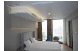
No.12 ホテルへの高効率インバーター・エアコンの導入(客室内に設置された室内機)
