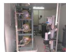
No.15-2 海水淡水化システム (中空糸逆浸透膜設備部)
