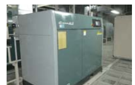
No.17 半導体工場における省エネ型冷凍機・コンプレッサーの導入(コンプレッサー)
