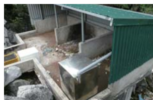
水上村に建設されたコンポストヤード
