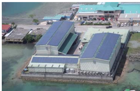
41 屋根置き太陽光発電システムの導入(パラオ)
