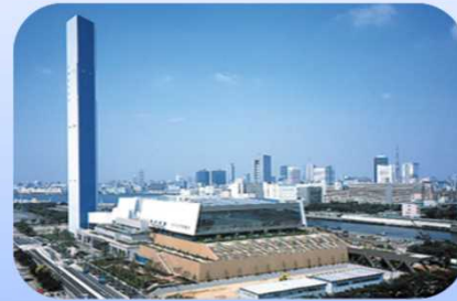
ごみ焼却発電施設
