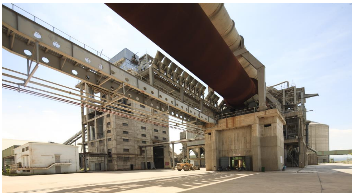
図 2.6 タンロンセメント社工場生産設備(写真提供:タンロンセメント社)
