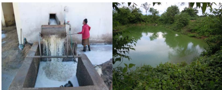
写真 2. 工場から排出される有機廃水(左)、既存のオープンラグーン(右)
