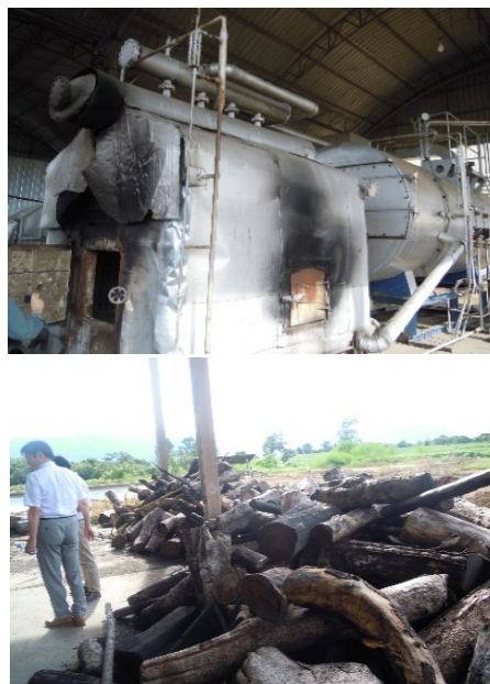
写真 1. KPN 社で使用している石炭/木材用ボイラー（上）、ボイラーの燃料として使用されている伐採木（下）
