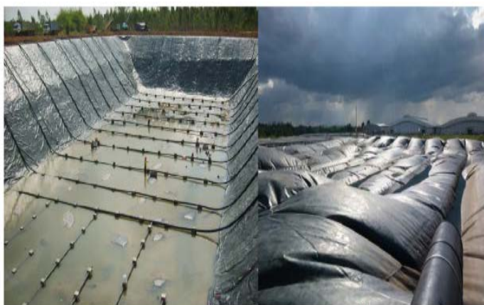
写真 3. FLR 形式のバイオガスダイジェスター (左:HDPE 敷設時、右:バイオガス発生時) (提供: Biotrix 社)
