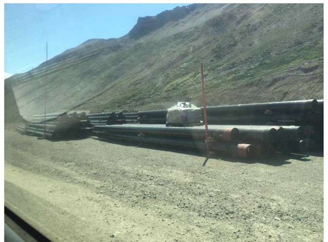
生産井用ケーシング(掘削準備を進めている)
