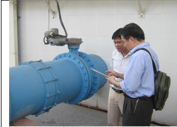
浄水場の視察状況
