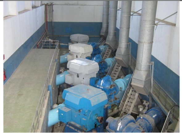
浄水場の視察状況
