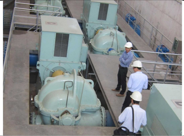
浄水場の視察状況
