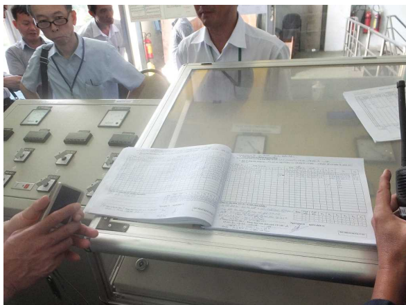
写真 既存の計測機及び記録方法(Tan Hiep1 浄水場)
