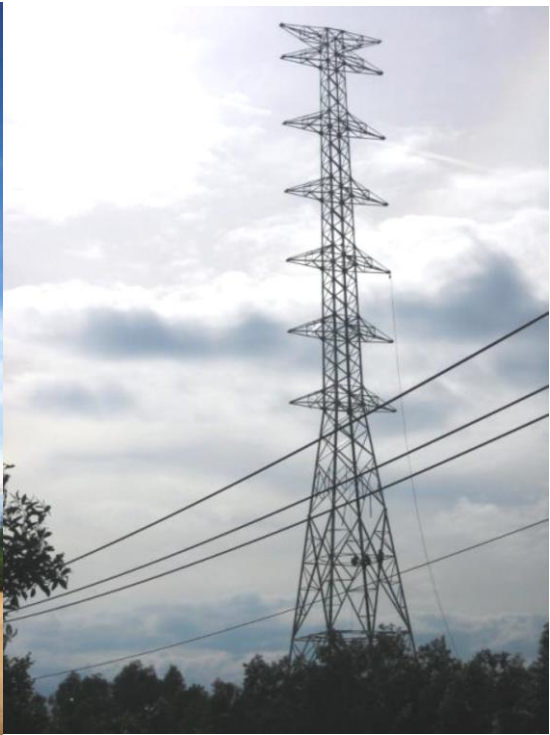
図 4-7 : 220kV, 4 回線 コーボン-ドクホア間に建立された送電線
