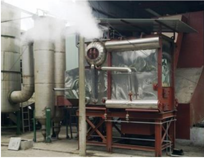
図 4-35 : 48ton/日の処理能力、発電機能を有する焼却炉
