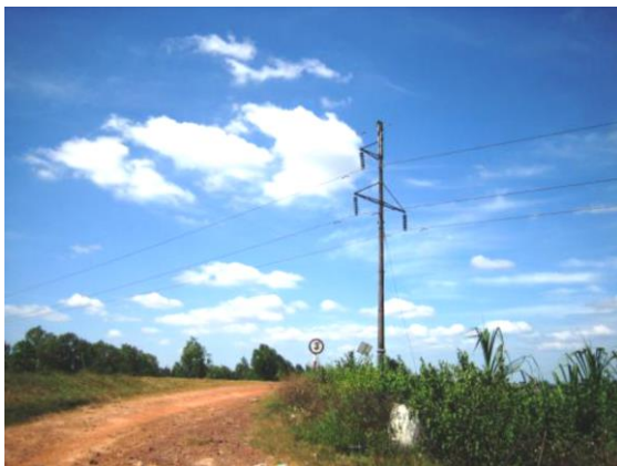
図 4-8 : 110kV クチ - トランバン送電線
