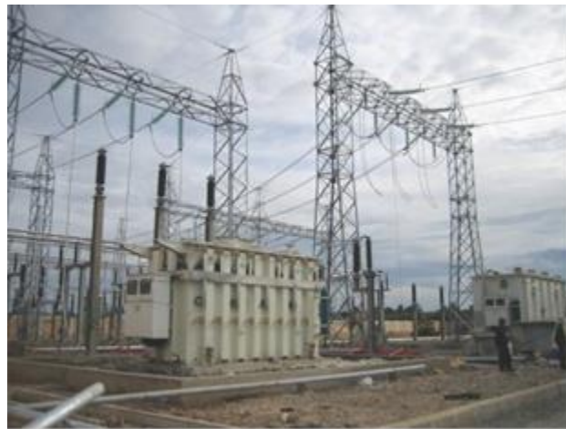
図 4-5 : 220/110kV 建設中のドクホア変電所
