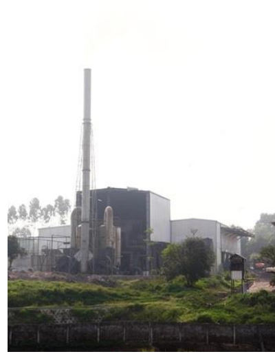
図 4-36 : 300t/日 (150t/日×2)の焼却炉 34
