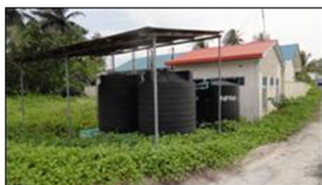
屋外燃料タンク（5kLタンク×6基）
