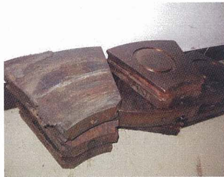
写真-4.2 焼損したスラスト軸受
