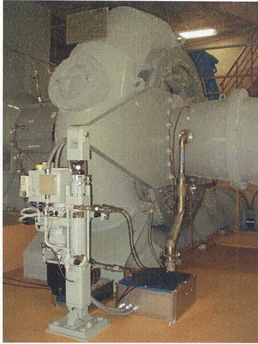
写真-4.5 ハイブリッドサーボ 出所:調査団作成
