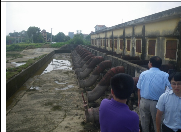
【第1回現地調査】 Thuon Le II ポンプ場の視察状況
