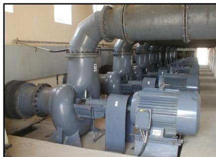
導入予定のポンプと同タイプの高効率ポンプ(荏原製作所製)
