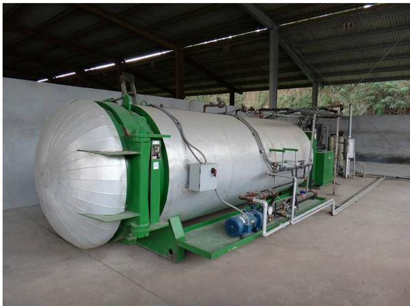
検討対象である蒸気滅菌処理施設は、主要設備としてオートクレーブ釜、真空ポンプ、電気式ボイラー、給水装置等で構成されている。
