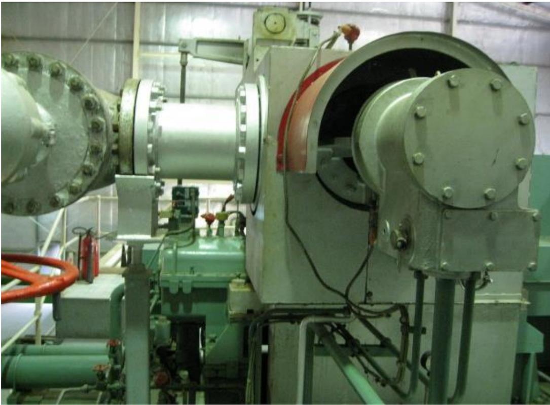
図 4-8 既設のシンコー製 10MW タービン
