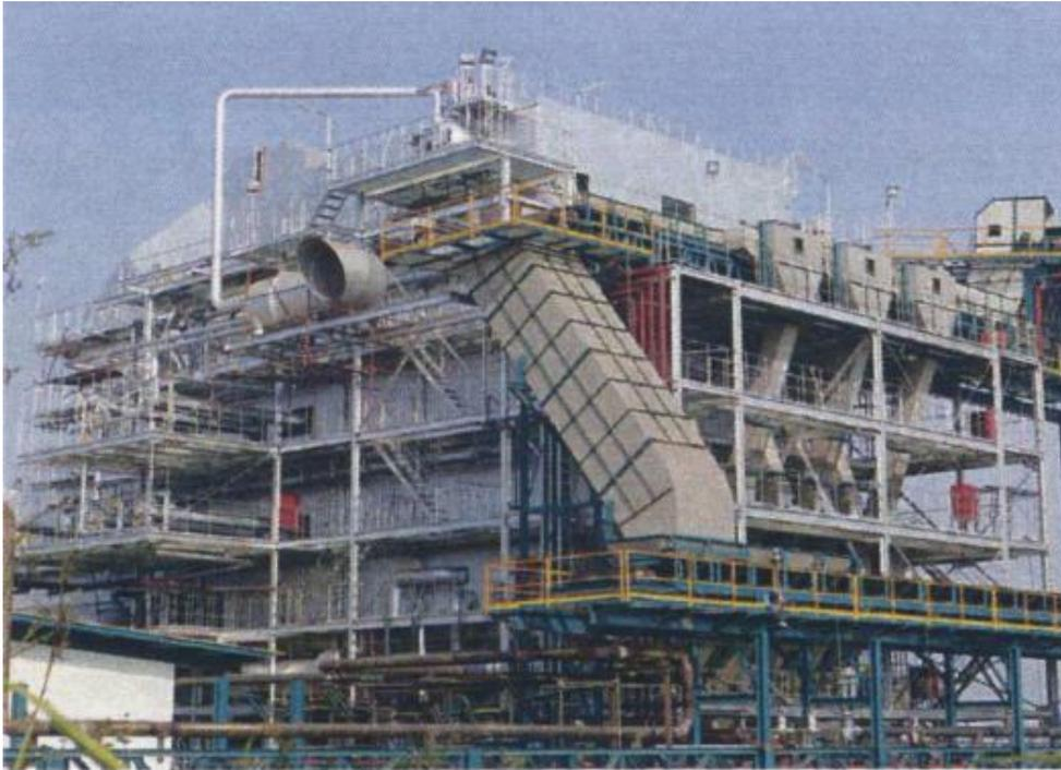
図 4-7 高温高压タイプバガス燃焼ボイラの概観
