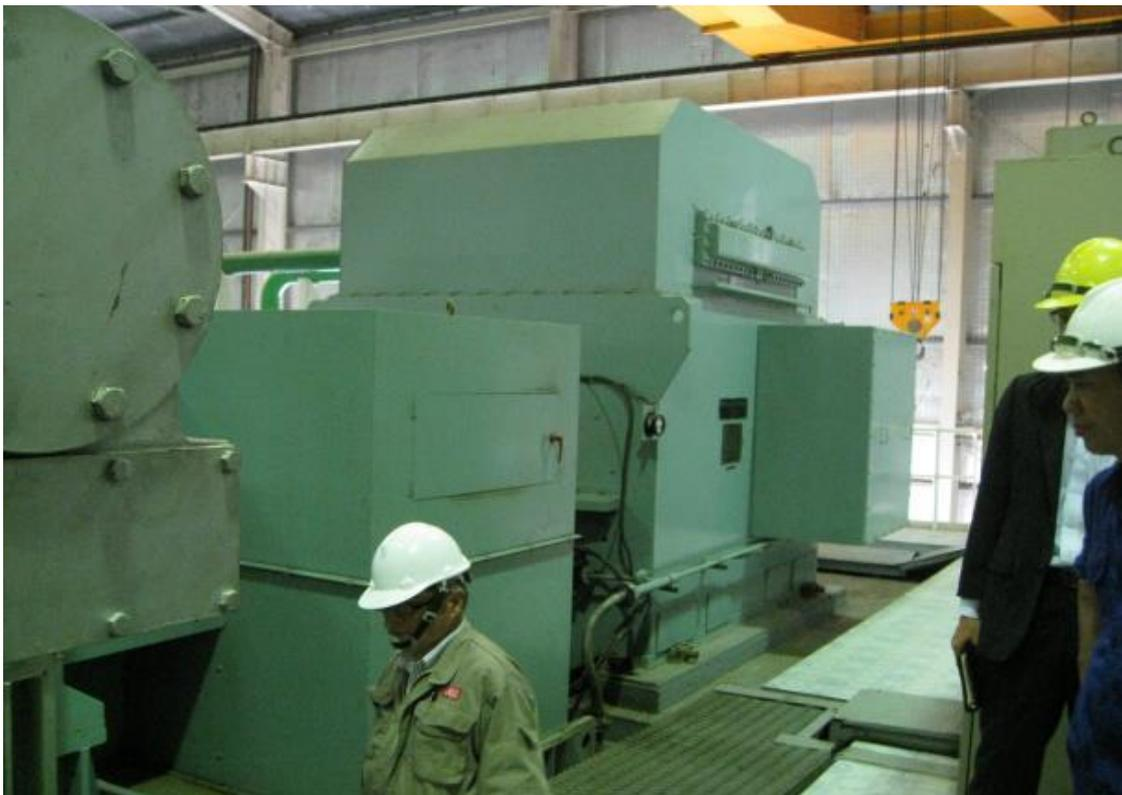
図 4-9 既設の西芝電機製 10MW 発電機
