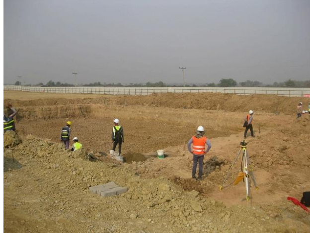
写真 4.1.2-5 建設中の管理型処分場
