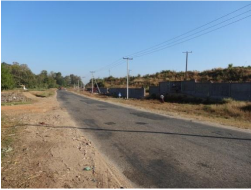
写真 4.1.2-1 建設予定地前面道路の高架配線(1. 1kV)
