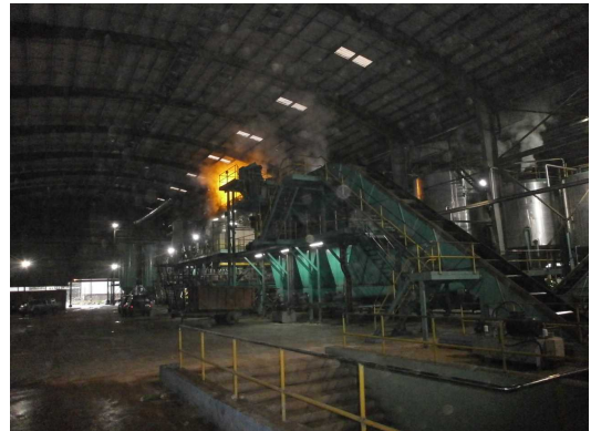
パーム搾油設備
