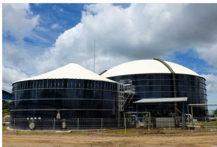
写真 バイオガス生成設備の外観例(マレーシア国、写真クボタ)
