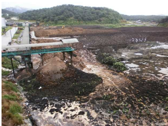
写真 EFBヤードの外観
