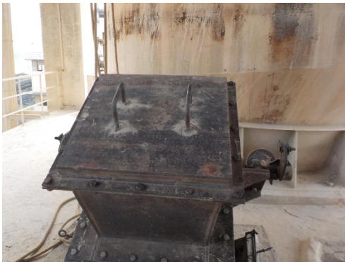
実験終了後 カバーをかけられた仮設投入装置
