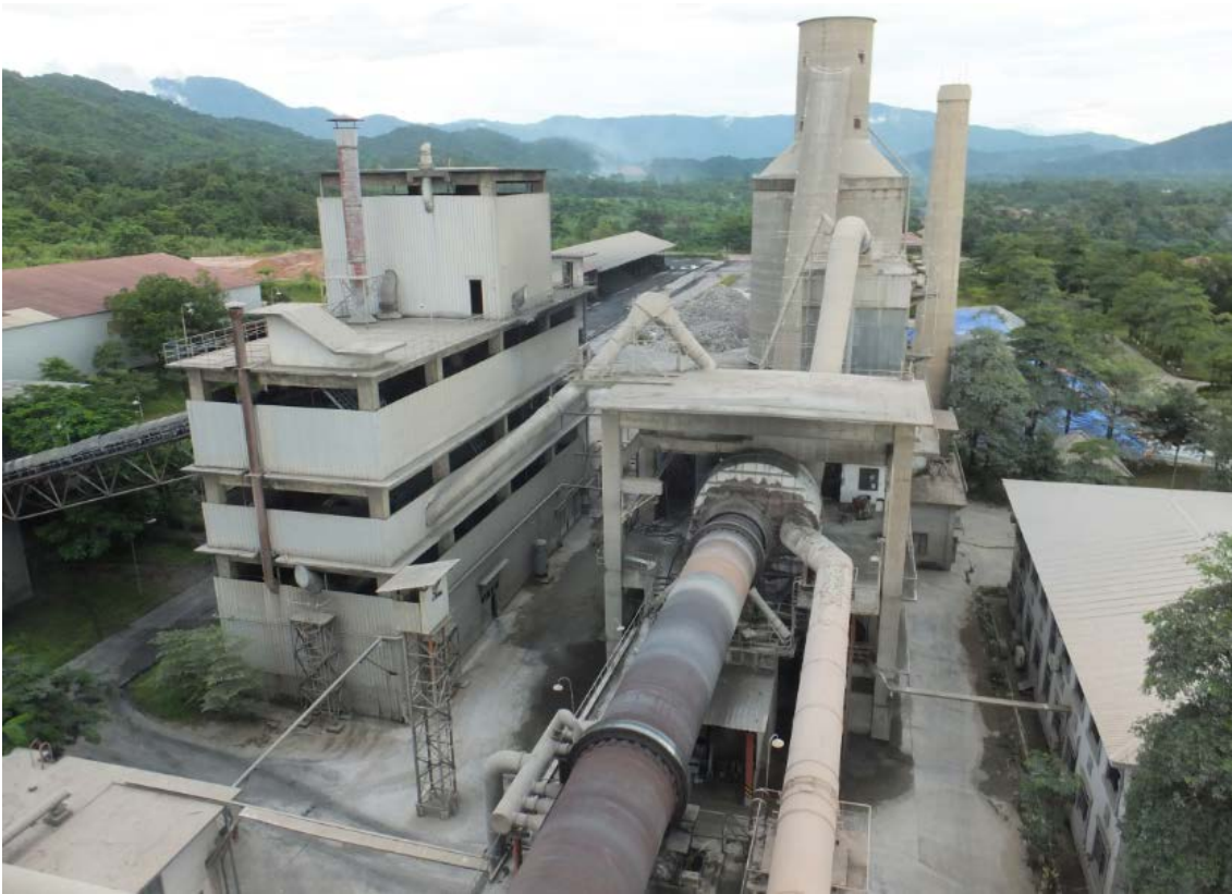
Lao Cement 工場と周辺環境
