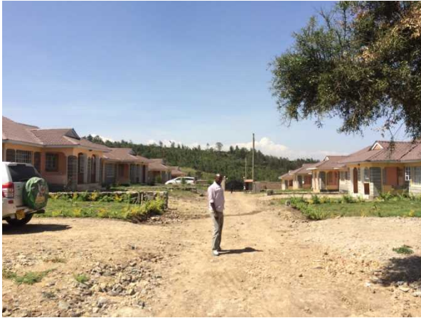
戸建住宅建設現場
