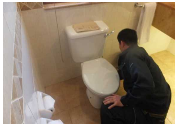
トイレの検証風景
