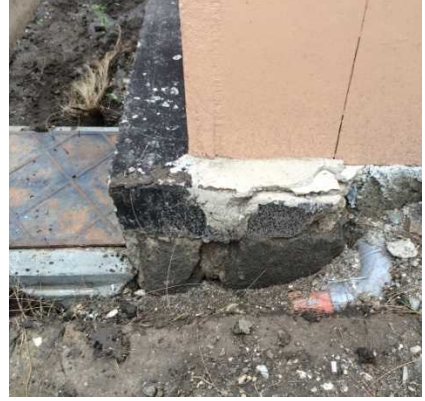
外溝配管写真
