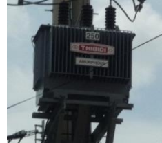
高効率アモルファス変圧器 (日立金属。ベトナム)
