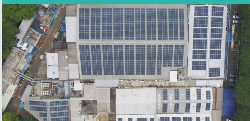
太陽光発電（インドネシア）アラムポート
