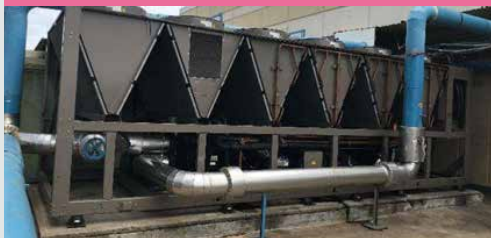
空冷チラー（ベトナム）日立ジョンソンコントロールズ空調
