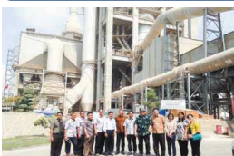
セメント廃熱回収発電 (JFEインダコリアン)
