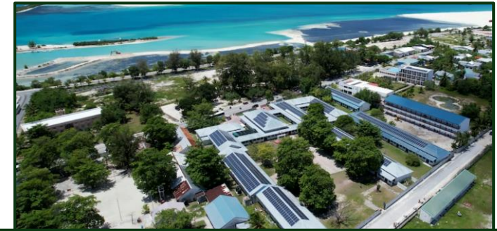
先進的フロー型蓄電池導入による再エネ導入促進&海洋再エネパイロットPJ（モルディブ）
