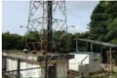
携帯電話基地局へのトライブリッド技術導入（KDDI）
