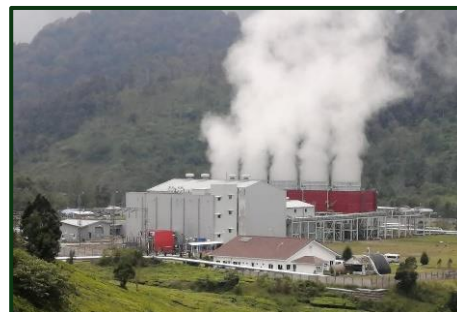
パトゥハ2号 55MW地熱発電（インドネシア）
