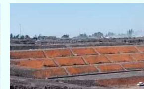
処分場改善（福岡方式）
