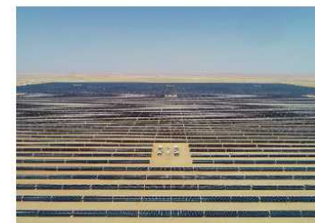
アミン太陽光発電プロジェクト (オマーン 105MW)
