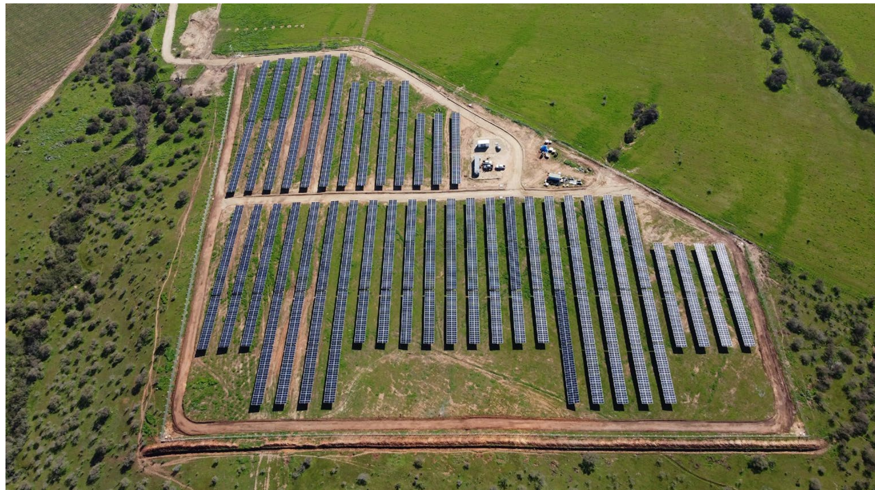
PMGD San Antonio Malvilla (3 MW)
