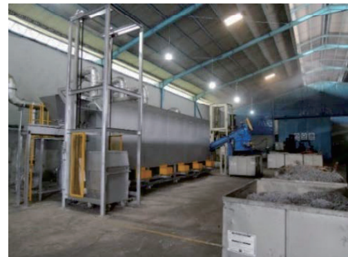
300kg/時間連続式アルミ切粉脱脂実証設備
