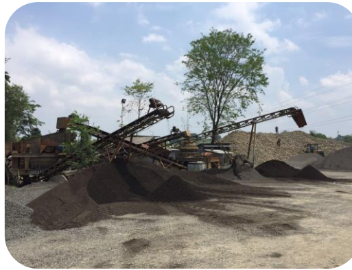
写真1 アスファルト廃棄物
