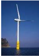
浮体式洋上風力発電
