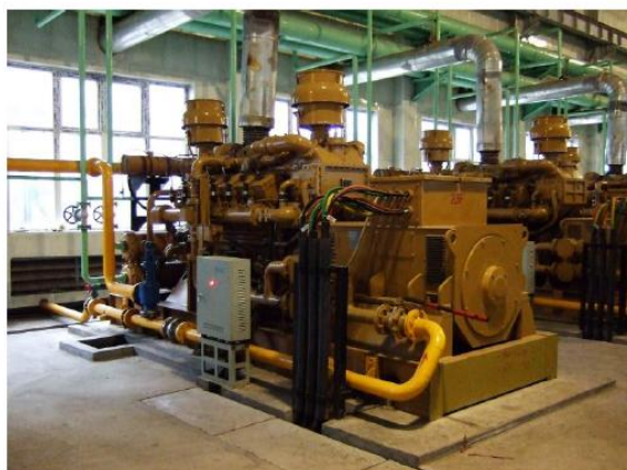
CMMガスエンジン発電機 (CH 4 濃度30%以上のCMM)
