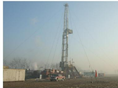
地表からのボーリング風景
