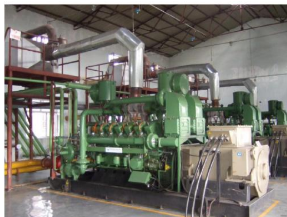
低濃度CMMガスエンジン発電機 (CH 4 濃度8%以上のCMM)
