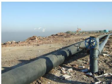
地表のボーリング口 CBMは抽出センターまで輸送される
