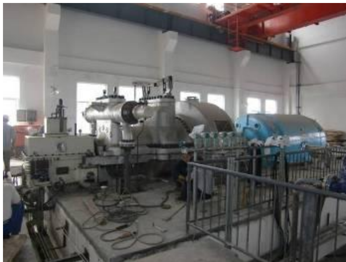
図 7 建設中のタービン及び発電機
