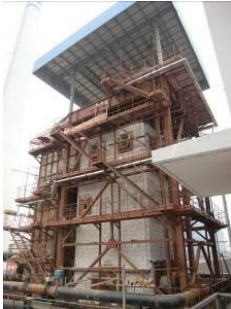
図 6 建設中の廃ガスボイラ
