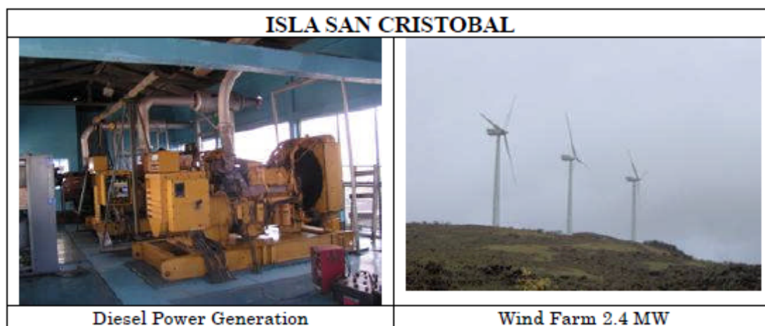
図 1-14 : サンクリストバル島における火力発電所及び風力発電所
