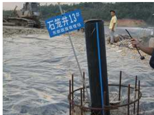
図 2-4-2 ガス抜き管
