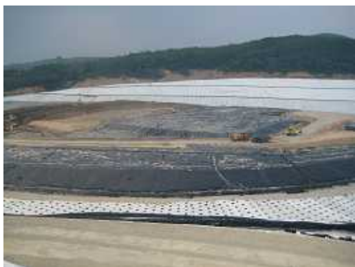
図 2-4-1 東部最終処分場全景
