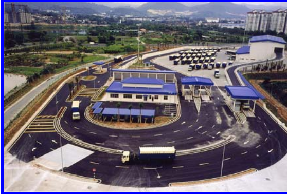
KL 市廃棄物中継施設
