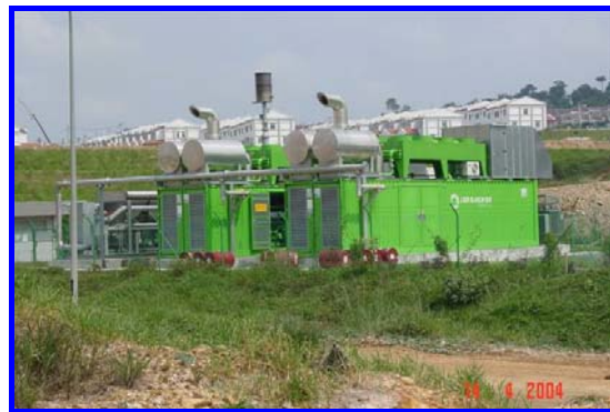
KL 市プチョン処分場 LFG 発電施設
