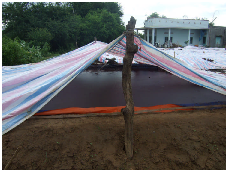
苗畑に設置された有機肥料生産設備
