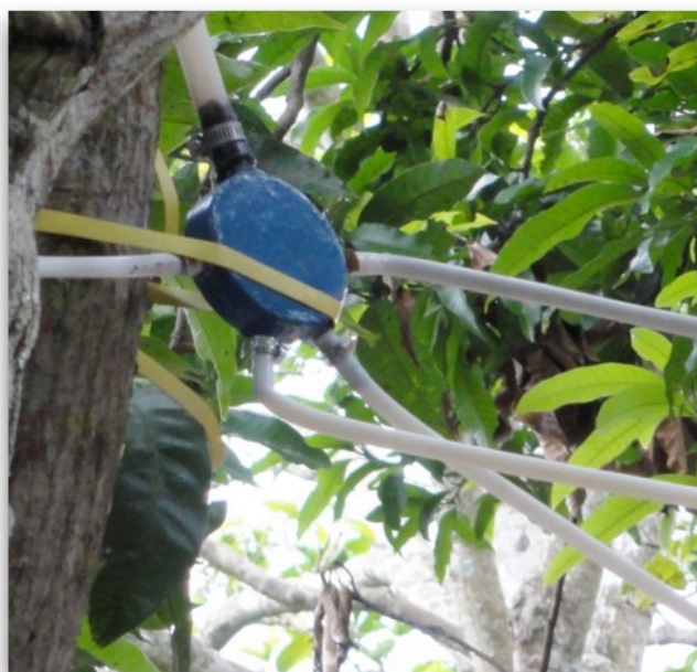
ガスチューブによる簡易配送網 (PJは地中配管)
